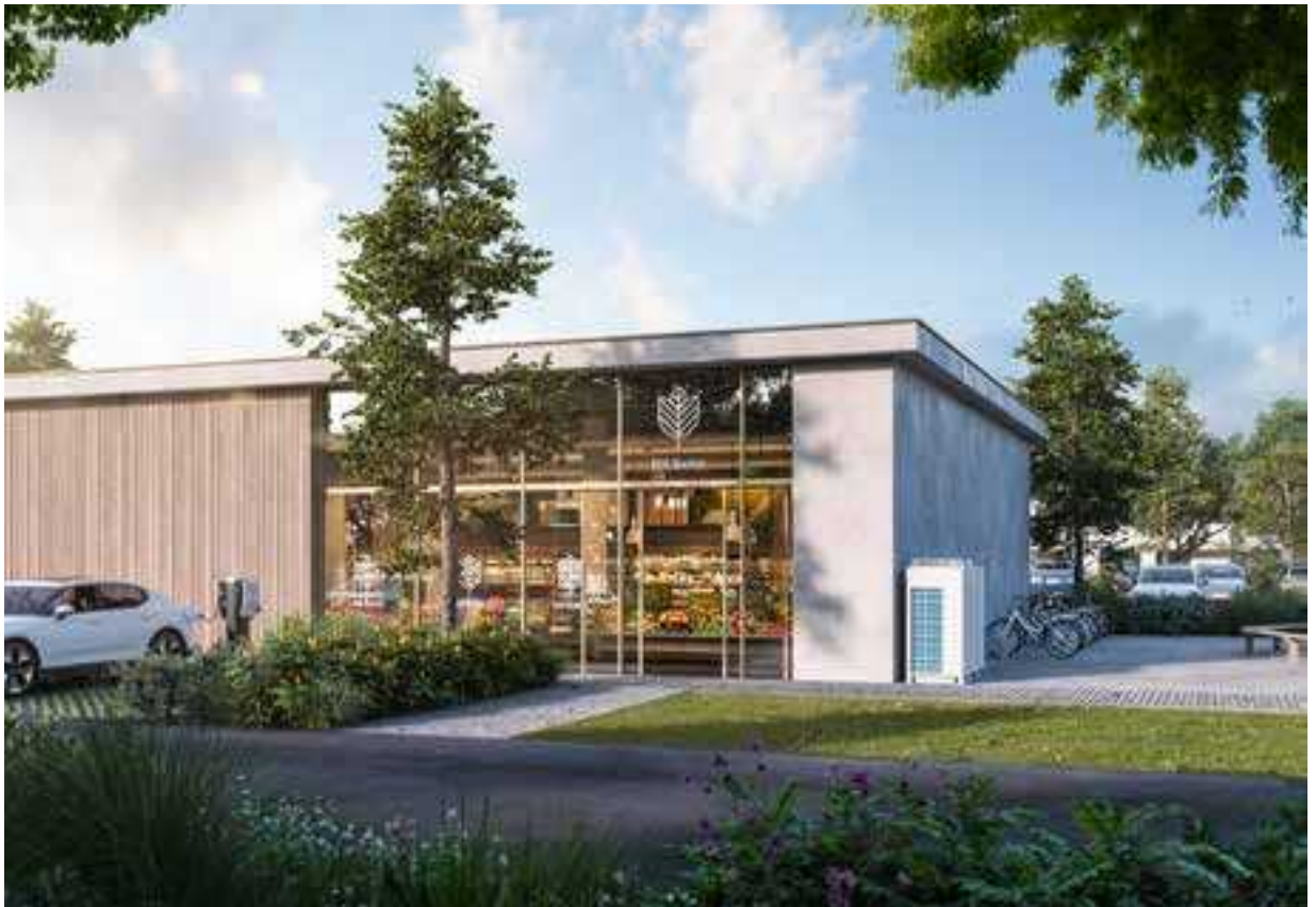
Beispiel einer Installation von CO 2 -VRV in einem Supermarkt
